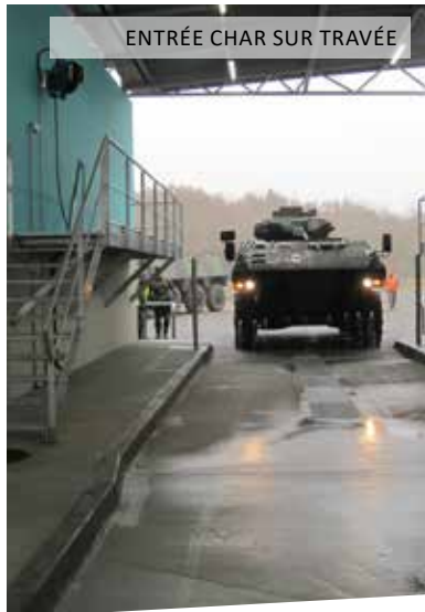
TRAVÉE DE LAVAGE VBCI
