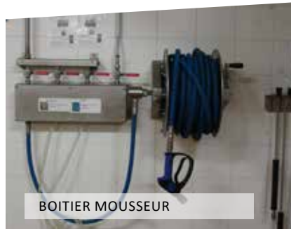
DOUBLE-COMPACT POUR RESEAU CENTRALISÉ
